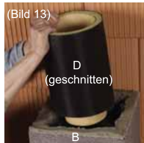
(Bild 13) Muffenrohr in den Mantelstein einführen und mit darunterliegendem Muffenrohr zusammenfügen.
