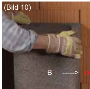
(Bild 10) Je nach RA-Anschlusshöhe (Bild 3, I bis IV) ist der entsprechende Mantelstein aufzusetzen.
