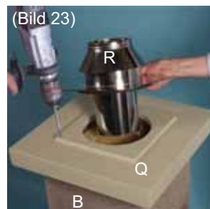
(Bild 23) Gewünschte Abdeckung z.B. Kamin-Fertigkopf etc. auf Mörtelbett aufsetzen. Mündungskonus* in Muffenrohr einführen und mit Dübel und Schrauben befestigen. * Im Grundpaket
