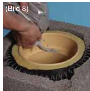
(Bild 8) Fugenkitt in Muffen gleichmäßig und durchgehend auftragen.
