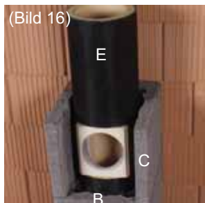
(Bild 16) Rauchrohranschluss - Formstück inkl. Isolierschale* mit darunterliegendem Muffenrohr zusammenfügen. Geschnittene Mantelstein versetzen. * Im Rauchrohrpaket
