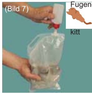
(Bild 7) Fugenkitt* vorbereiten. ACHTUNG: Der Fugenkitt ist genau nach Anleitung zu verarbeiten! * Im Grundpaket
